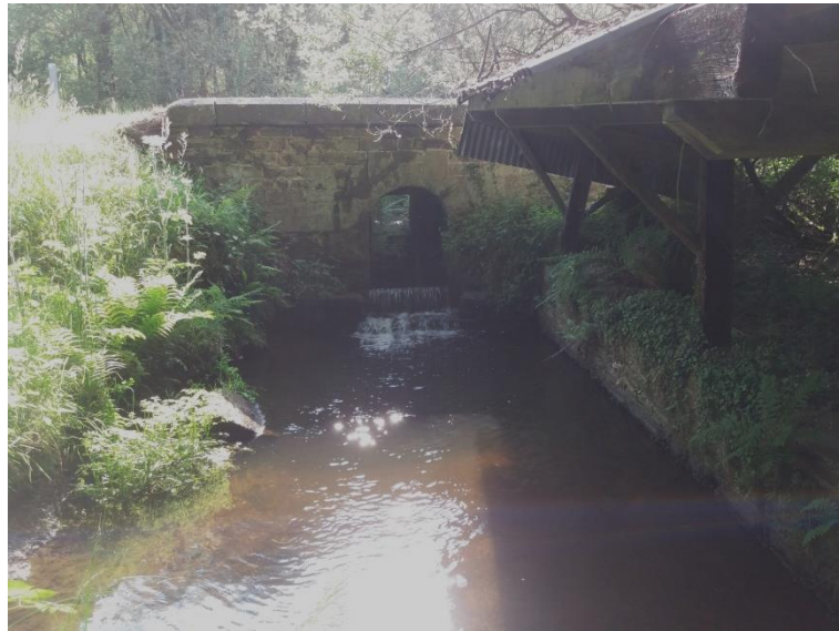
Photo 2 : OH2 (1,00 x 1,20) sous la RD 782
