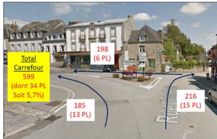
Figure 4 : Le carrefour RD782/RD790a - Place des Halles
